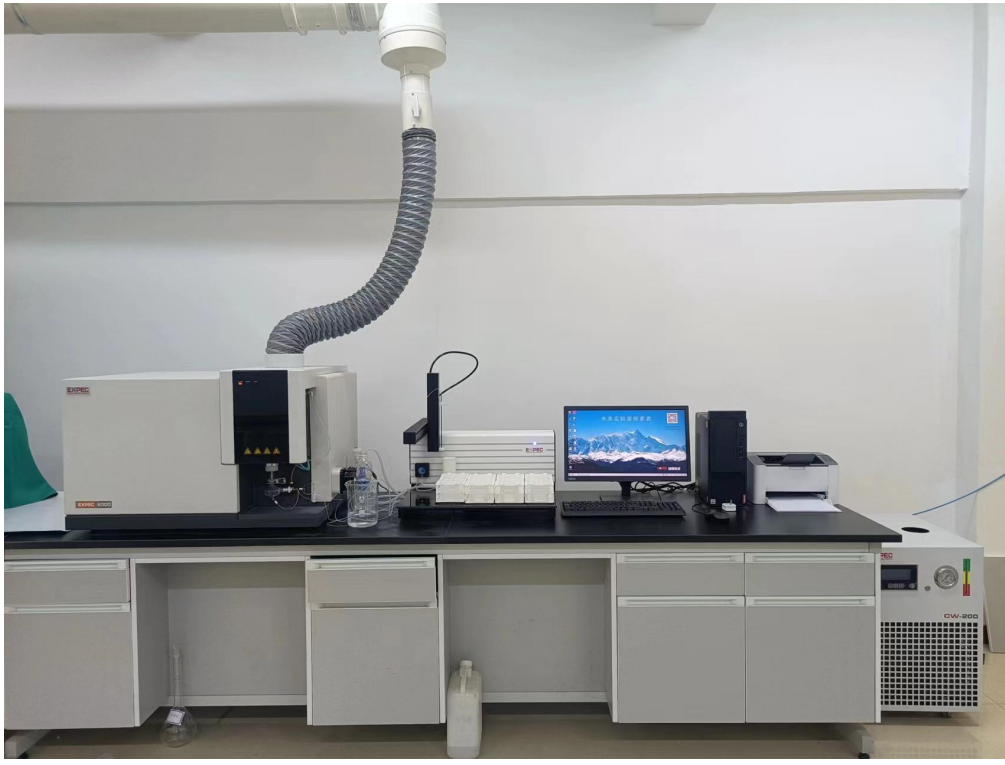
现场安装效果-正面
